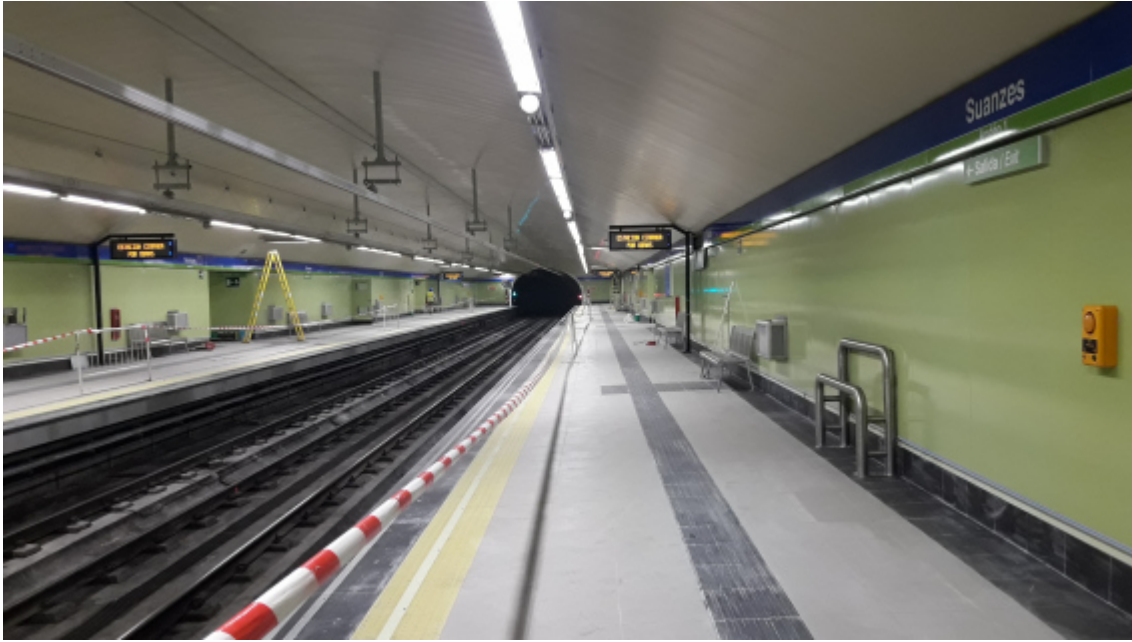
Balizamiento de ambos andenes
